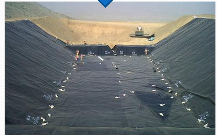
RELLENO DE SEGURIDAD
